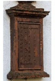
Igreja da Ordem Terceira de São Francisco, an der Seite der Seilzug für die Glocke, auf dem Kasten ist der Glockenplan, je nachdem wo Hilfe nötig ist
