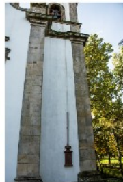
Igreja da Ordem Terceira de São Francisco, an der Seite der Seilzug für die Glocke, auf dem Kasten ist der Glockenplan, je nachdem wo Hilfe nötig ist
